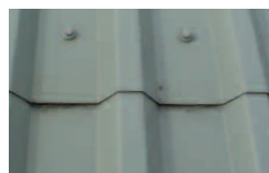
Tetto Colorcoat HPS200 Ultra® con Galvalloy™, dopo 7 anni.
