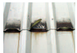
Dak van standaard plastisol op dompelverzinkt staal na 7 jaar.
